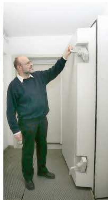
Rüdiger Heußinger, Fachbereichsleiter Öffentliche Sicherheit, an einer der Bunkertüren aus Stahl und Beton.
